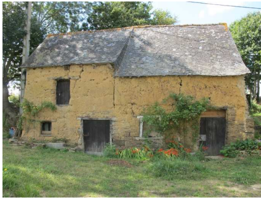
La Boulaie, exemple de mise en œuvre en terre selon la technique de la bauge, commune des Champs-Géraux, © Région Bretagne, Véronique Orain, 2010
