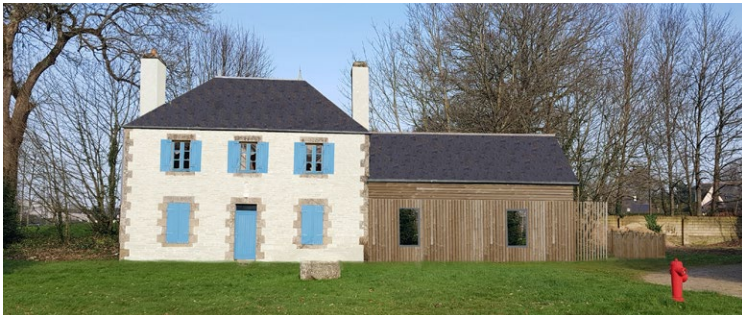
Le projet de rénovation de la maison du gardien © Architecture CAO
