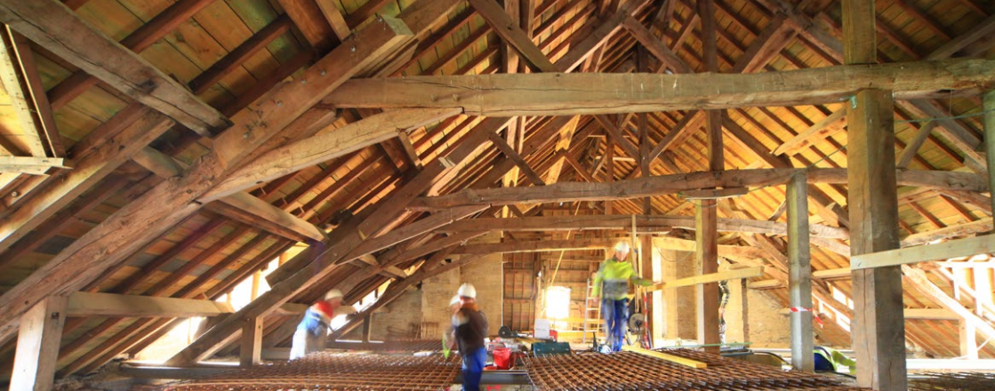
La charpente d'origine, consolidée et rénovée lors des travaux réalisés en 2011 © Panoramic Bretagne
